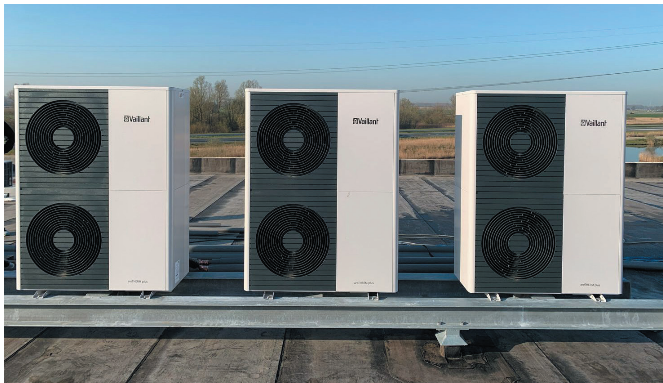
Exemple de cascade de pompes à chaleurs air / eau collective (aroTHERM plus)
